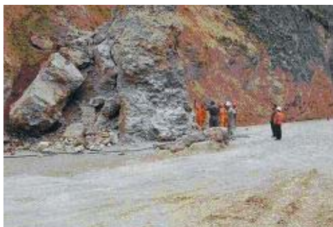
岩石の撤去作業（フニン地域ハウハ〜タルマ間道路）
