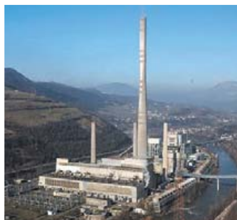
カカニ火力発電所
