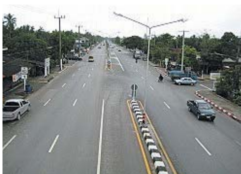
拡幅された国道403号(ナコンシータマラート～国道41号ジャンクション)
