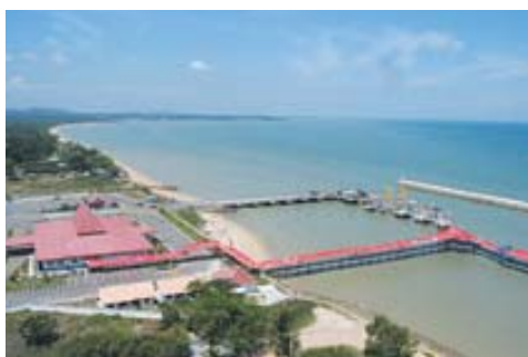
本事業により建設されたフェリーターミナル(ムントク)
