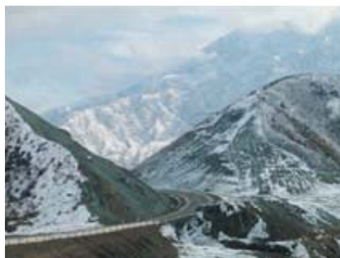
改修された道路(コクベル峠)
