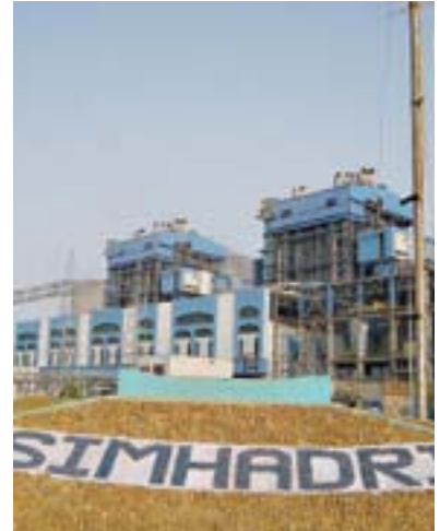
シマドリ発電所
