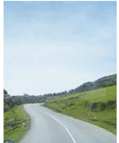
補修されたディリー～カーサ道路
