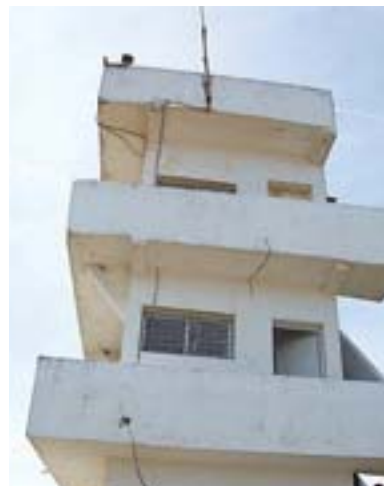
本事業で建設された監視所
