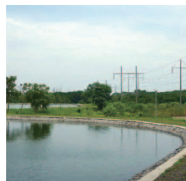
下水処理場の安定化池
