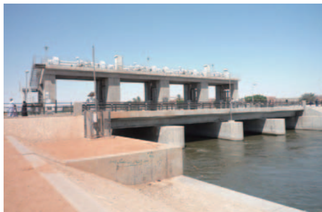
改修されたサコーラ堰(エジプト)
