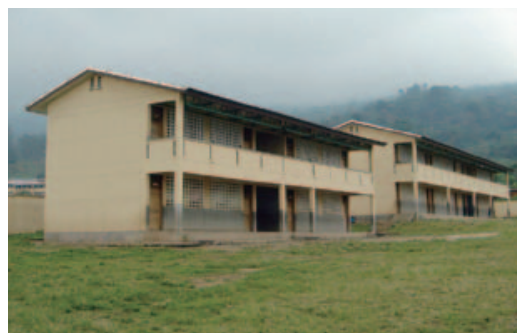
建設された小学校(南西州)
