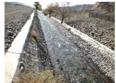
幹線水路（トルファン）
