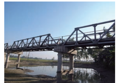
シラジゴンジ県に建設された橋
