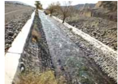
幹線水路 (トルファン)
