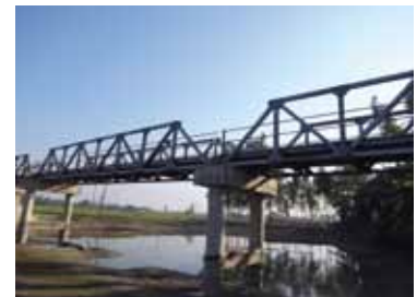
シラジゴンジ県に建設された橋
