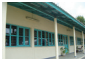
建設された教室（CFS*マシナ） ※CFS：基礎レベルの医療技術者を養成する訓練センター
