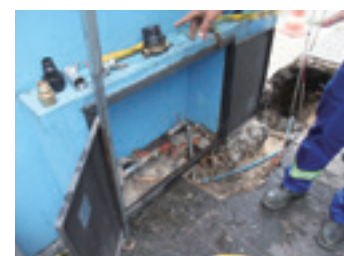
給水管布設替えの様子
