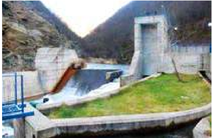
本事業で建設された取水堰
