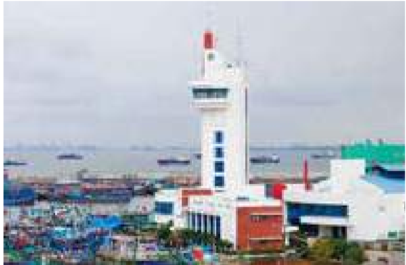
本事業で建設したコントロールタワー
