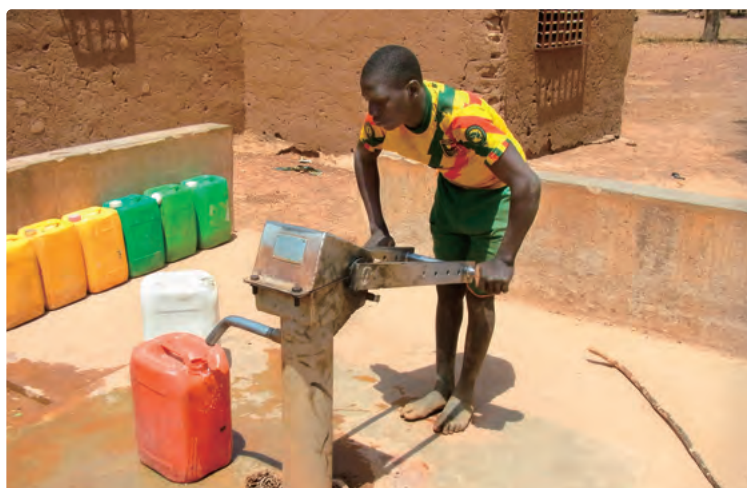
建設されたハンドポンプ付深井戸給水施設
