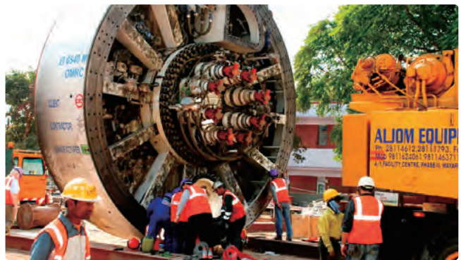
全断面トンネル掘進機の組み立て
