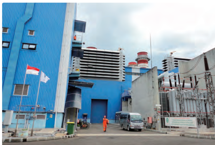
タンジュンプリオク火力発電所
