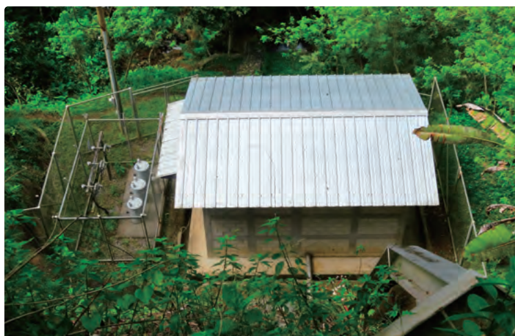
発電施設(セアシル)(写真手前から施設に入る管は水圧管)
