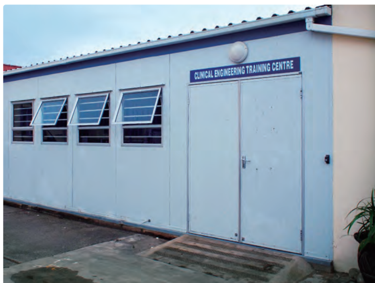
改修した研修施設(フレア病院)
