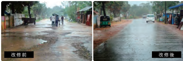
改修前と改修後の道路の一例(実施機関提供)
