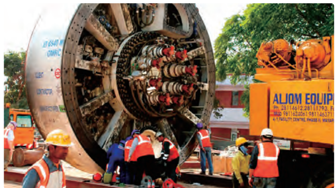
全断面トンネル掘進機の組み立て
