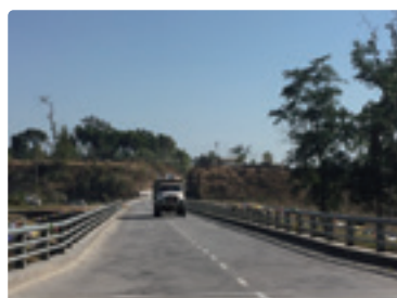
建設後のドルコラ橋
