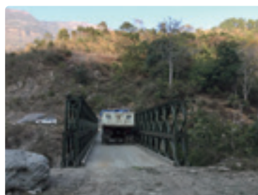
建設後のケラ橋
