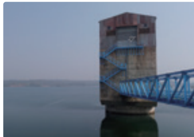
上ダムと取水口
