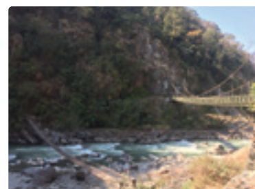
レオタラ橋の旧橋(手前)と新橋(奥)
