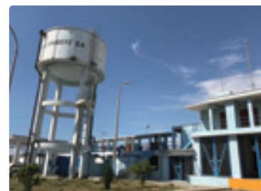
配水池(チンボテ市)
