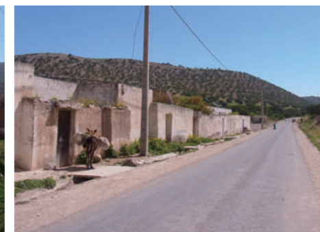
整備後の道路
