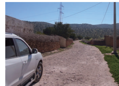
整備前の道路
