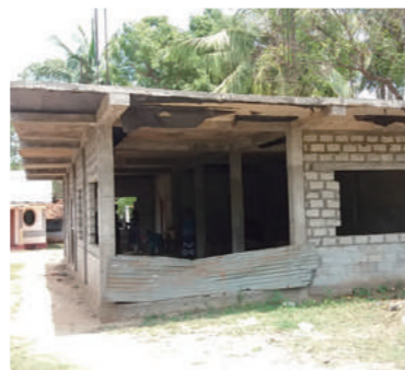
建設中の開発組合の食品加工所
