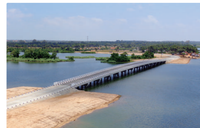
マンムナイ橋梁
