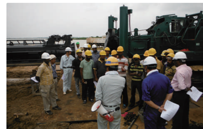
日本人と現地作業員の現場打ち合わせ
