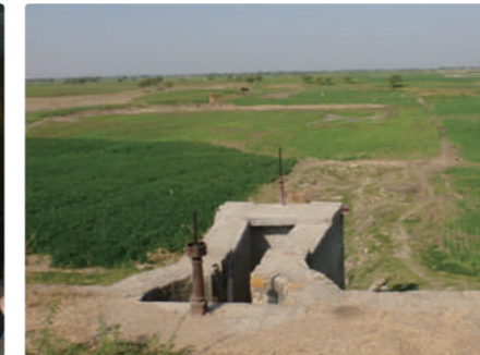
ダムの取水設備
