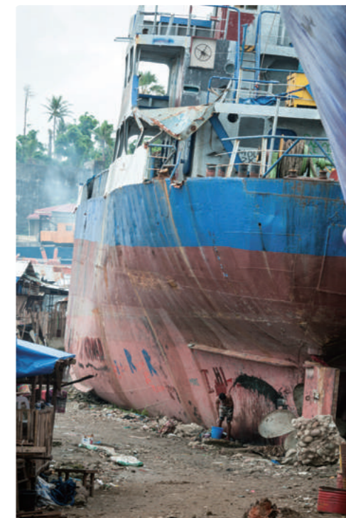
2013年11月の台風ヨランダによる被害の跡。大型船が陸に乗り上げたままになっている
