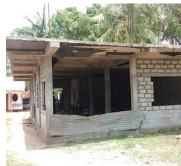
建設中の開発組合の食品加工所
