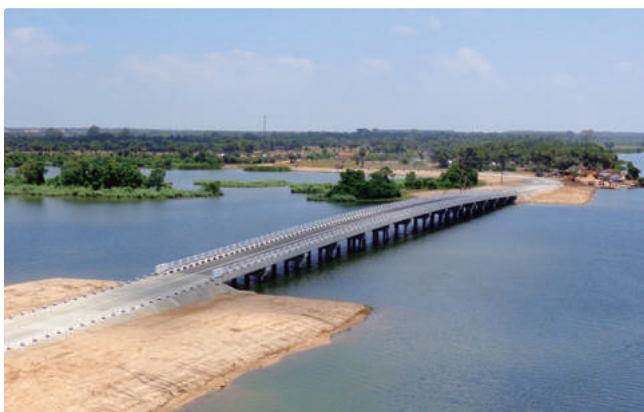
マンムナイ橋梁
