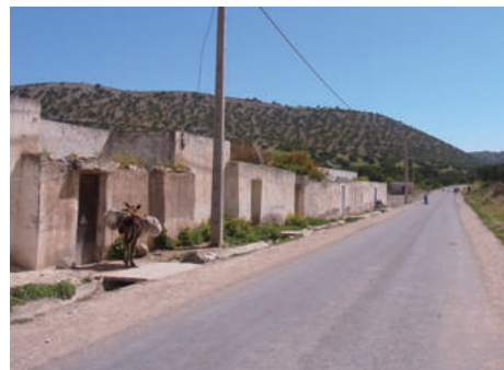
整備後の道路
