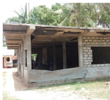
建設中の開発組合の食品加工所
