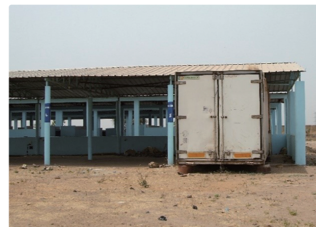
冷凍魚卸売人が使用する予定のコンテナ設置場所(中央魚市場)
