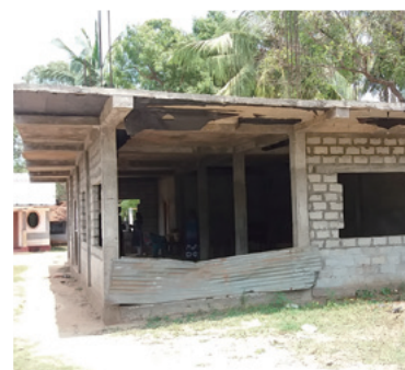
建設中の開発組合の食品加工所
