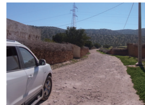
整備前の道路
