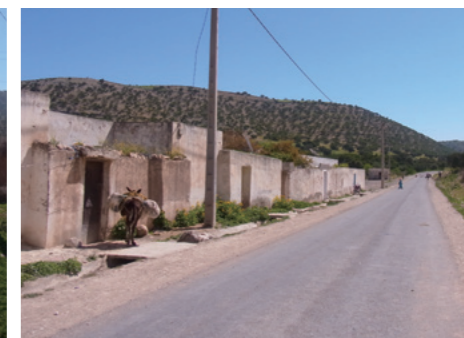
整備後の道路
