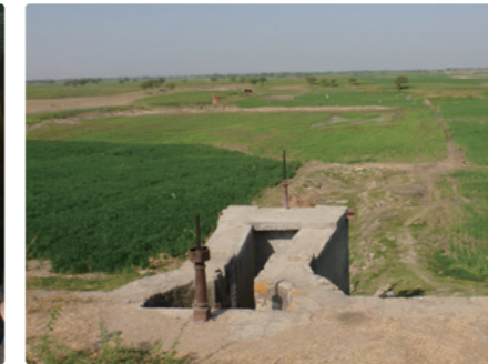
ダムの取水設備
