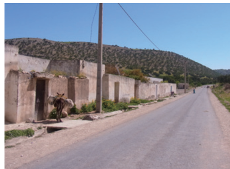
整備後の道路
