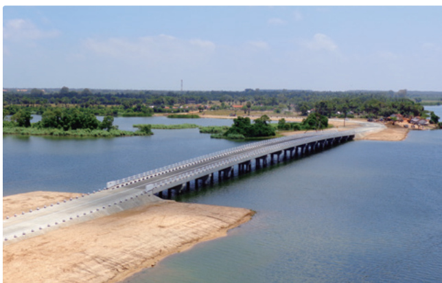
マンムナイ橋梁
