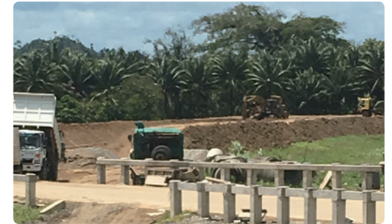
工事中のプラオ地区幹線水路
