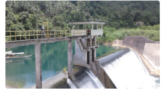
完成済みのカトゥビッグダム
