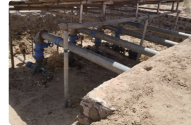
ソマリ州で建設された灌漑施設2
