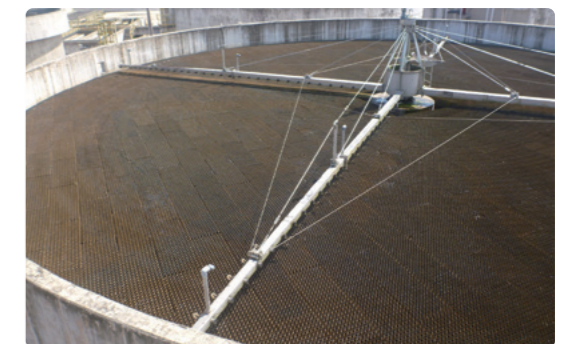
下水処理場（散水ろ床部分）
