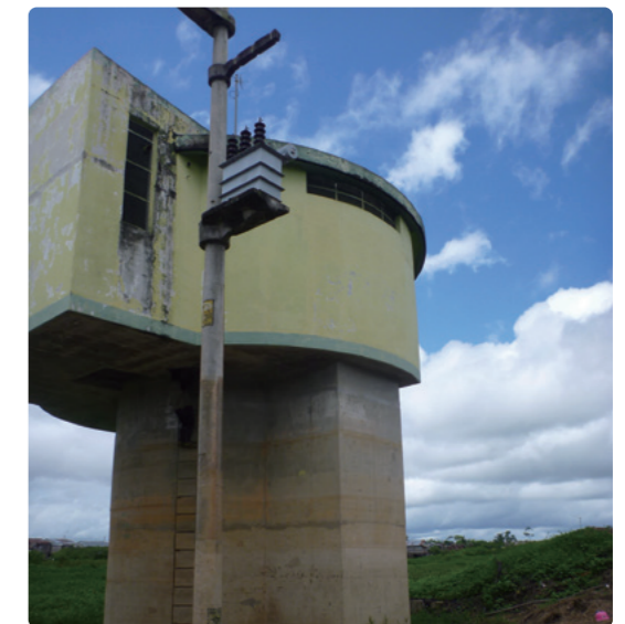
本事業で建設したポンプ場
