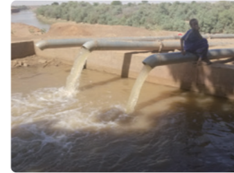
ソマリ州で建設された灌漑施設
