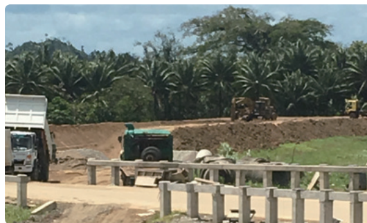
工事中のブラオ地区幹線水路
