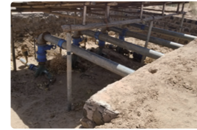
ソマリ州で建設された灌漑施設2
