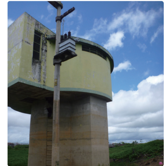
本事業で建設したポンプ場
