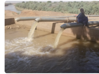
ソマリ州で建設された灌漑施設
