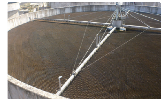
下水処理場（散水ろ床部分）
