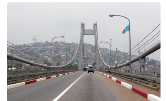
送気乾燥システムが設置されたケーブル。前方はマタディの街 撮影者:久野真一
