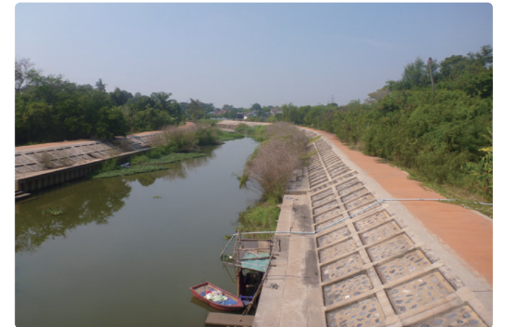
タイ「パサック川東部アユタヤ地区洪水対策計画」本事業で整備されたハントラ水路の護岸
