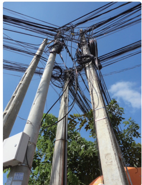
ローカルアクセスケーブル(架空線)
