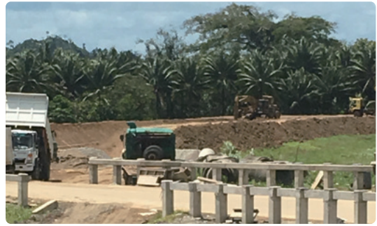
工事中のプラオ地区幹線水路
