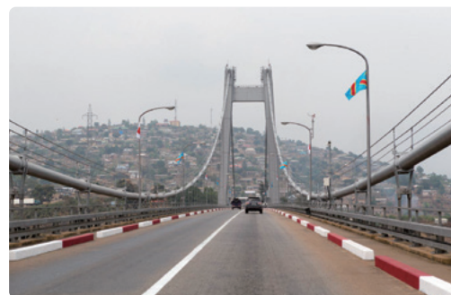
送気乾燥システムが設置されたケーブル。前方はマタディの街 撮影者：久野真一
