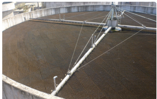
下水処理場（散水ろ床部分）
