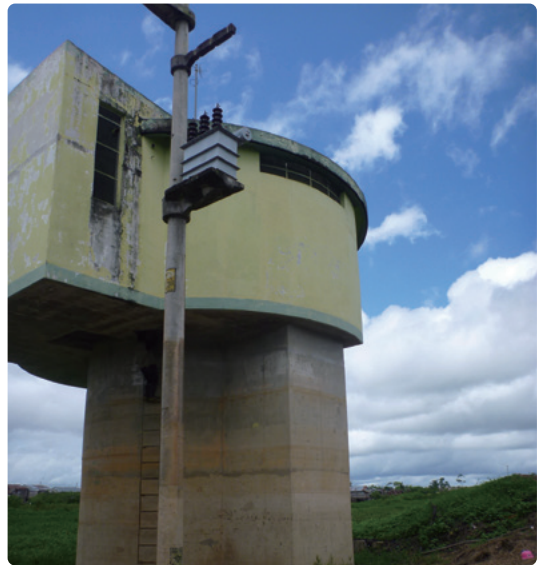
本事業で建設したポンプ場
