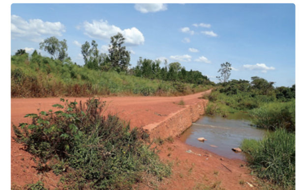
整備されたアクセス道路と河川横断・道路排水施設(オモロ県)
