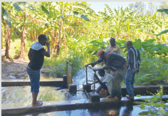
本事業で建設した取水堰と水利組合員
