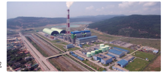
発電所全景(ベトナム「ギソン火力発電所建設事業」)
