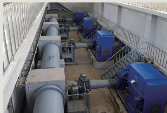
本事業で整備されたニューファナッピン第一期浄水場送配水ポンプ
