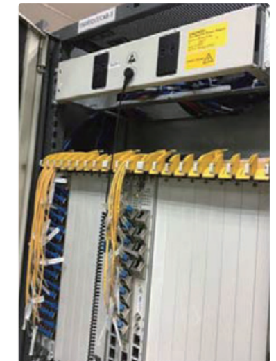
供給者側のブロードバンド回線設備
