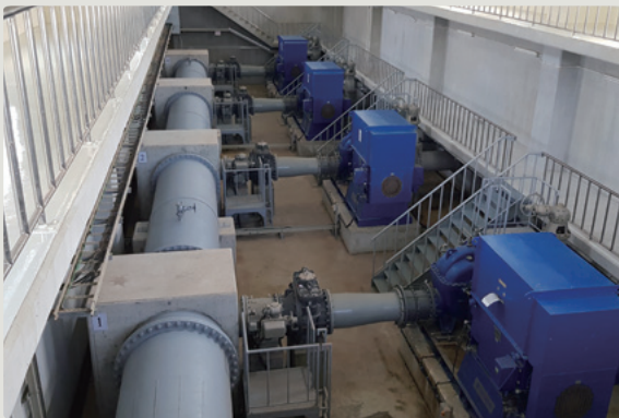
本事業で整備されたニャウフナッピン第一期浄水場送配水ポンプ
