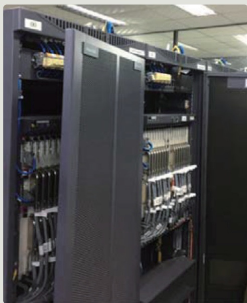
相互接続設備・機器
