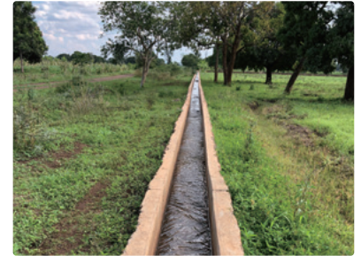
本事業で整備した水路
