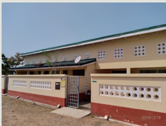
コミュニティーで妊産婦・新生児保健サービスを提供するCHPS コンパウンド
