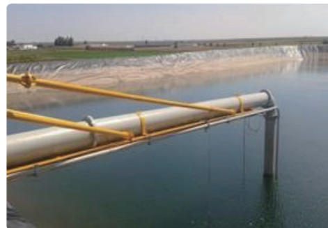
事業実施中の灌漑用水貯水池 (2011年～2016年)
