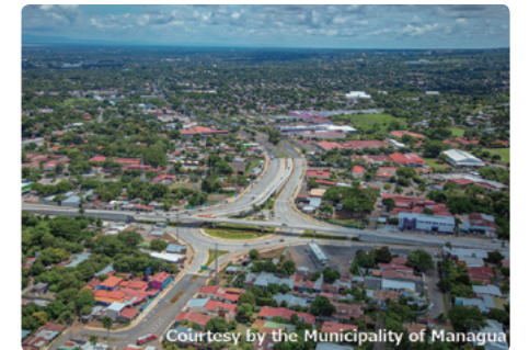
高架道路・交差点プロジェクトで整備された環状交差点と高架道路
