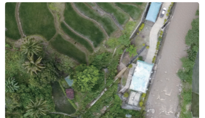
建設されたリクッド小水力発電所
