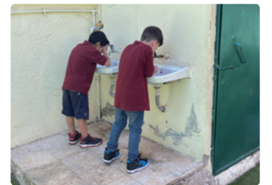
無償事業により給水量が増加し手洗いの水に困らなくなった小学校
