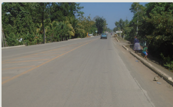
国道7号東線（第4工区）
