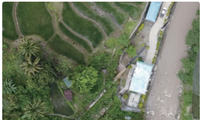
建設されたリクッド小水力発電所
