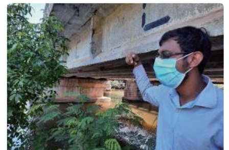
橋梁点検車を用いて点検された橋梁の1つ
