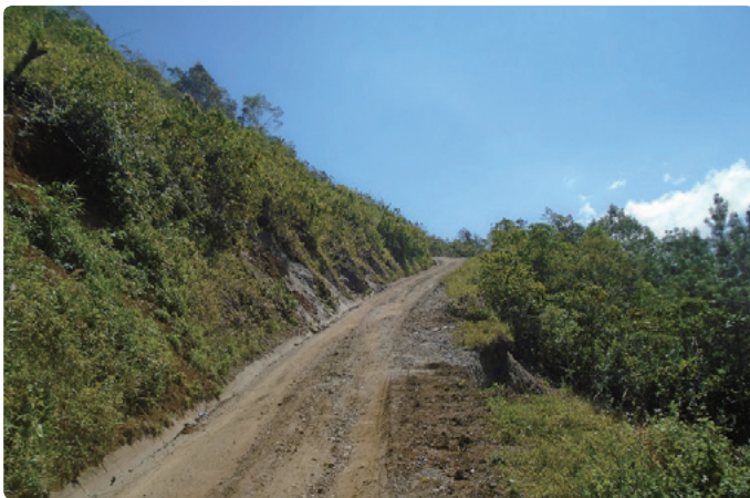
本事業により砂利舗装された農村道路
