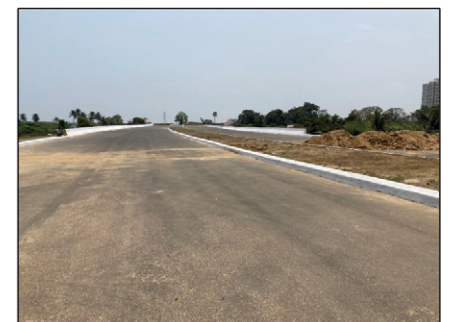
本事業で実施された 小規模インフラ事業 (バイパス道路建設)
