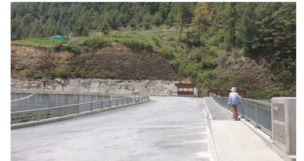
歩道を設置したニカチュ橋
