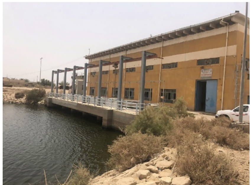
東ガラーフ排水ポンプ場
