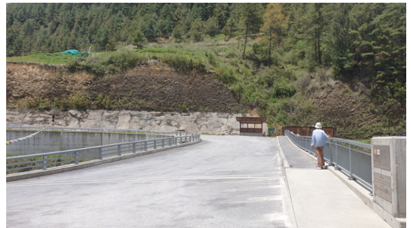
歩道を設置したニカチュ橋
