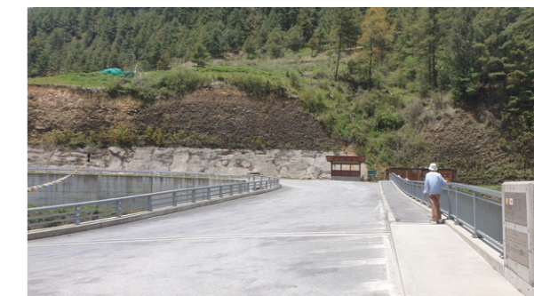
歩道を設置したニカチュ橋
