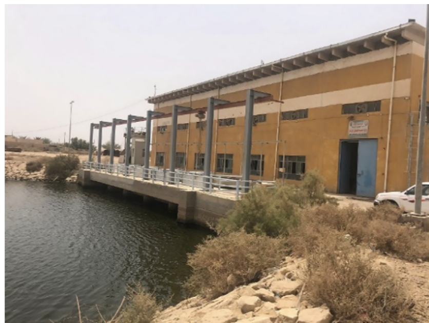
東ガラーフ排水ポンプ場
