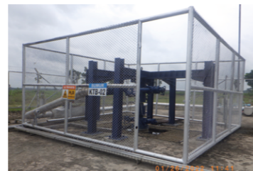
グンディガス田のCO 2 圧入を予定している井戸
