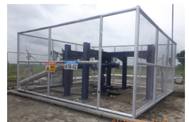
グンディガス田のCO 2 圧入を 予定している井戸
