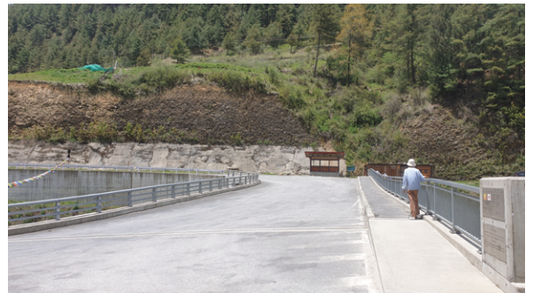
歩道を設置したニカチュ橋
