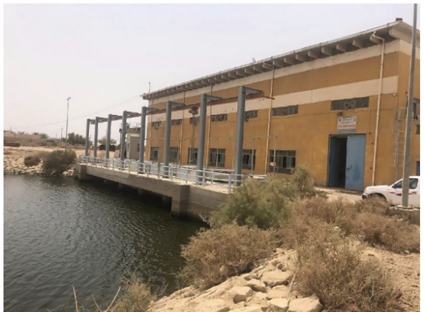
東ガラーフ排水ポンプ場
