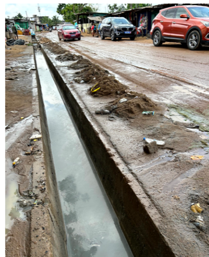
道路側溝の清掃 (ヨブゴン・コミュニティ)
