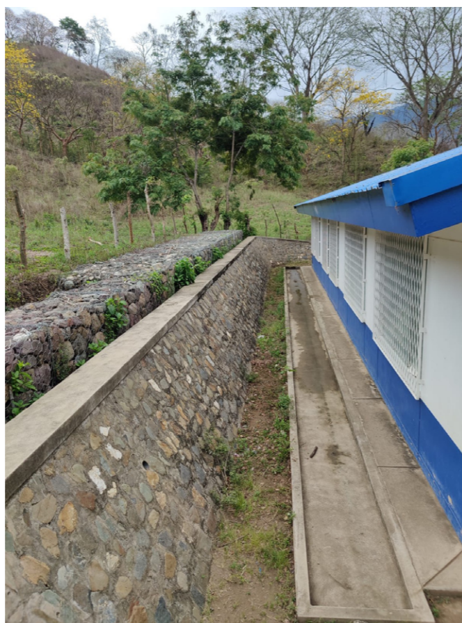
斜面からの土砂等を受け止める蛇かご 1
