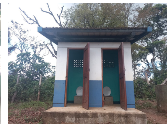
建設されたトイレ棟
