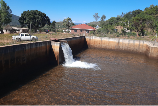
新設された貯水池
