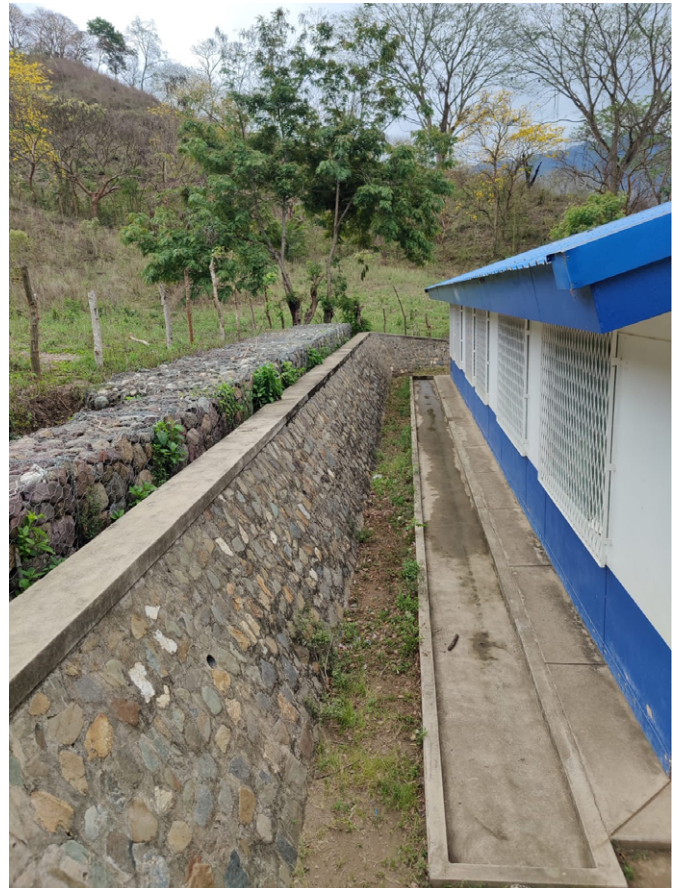
斜面からの土砂等を受け止める蛇かご 1
