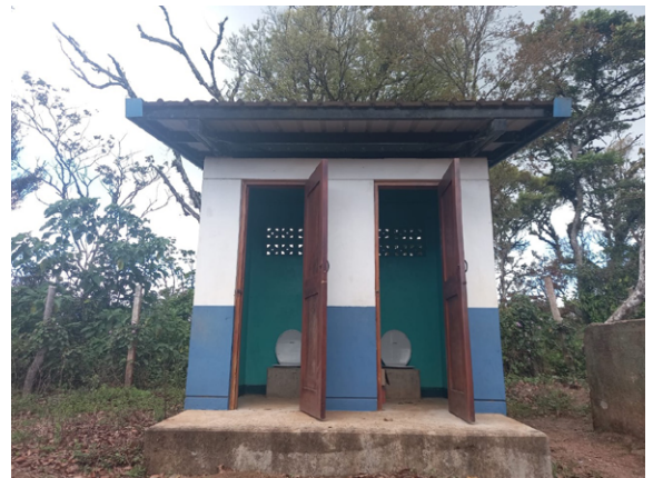
建設されたトイレ棟
