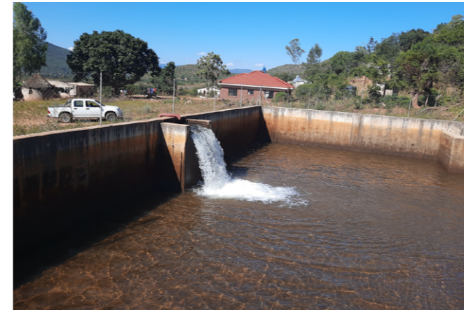
新設された貯水池
