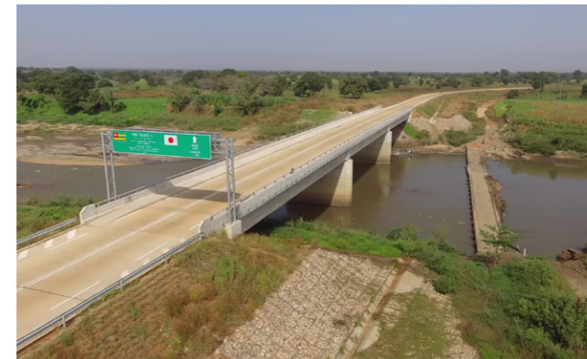
カラ橋(右側の小さな橋は事業実施前に使用されていた沈下橋)
