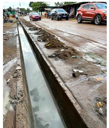
道路側溝の清掃(ヨブゴン・コミュニティ)
