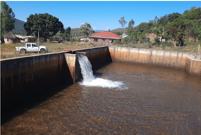
新設された貯水池
