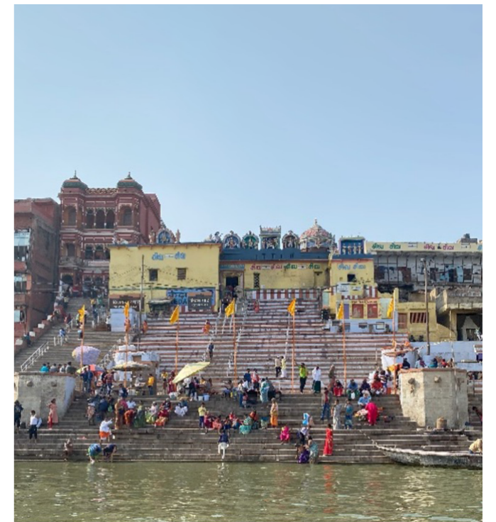
JICAの支援で改修が行われた沐浴場(インド(円借款)「ガンジス河流域都市衛生環境改善事業(バラナシ)」)
