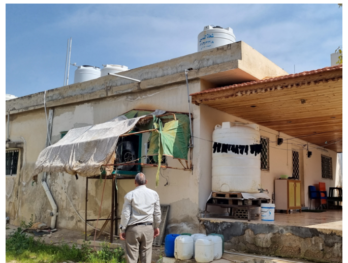
ヨルダン(無償資金協力)「バルカ県送配水網改修・拡張計画」の対象地域であるマアディ配水区アルバラッドでインタビューした家庭の家屋と水タンク
