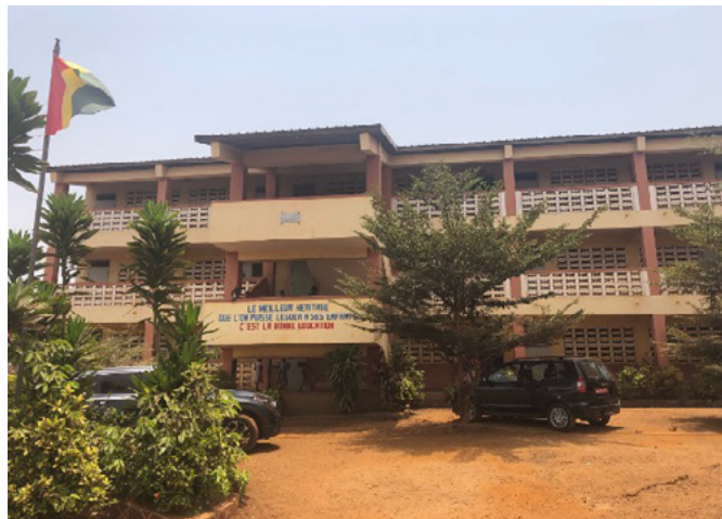
建設された校舎
