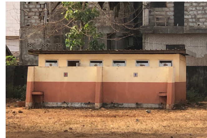
利用制限されたトイレ
