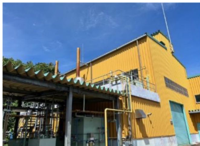
新設された発電所外観（撮影：外部評価者）
