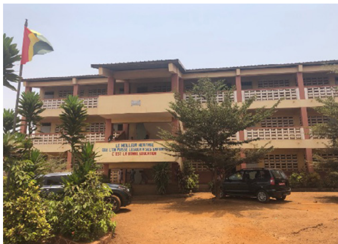
建設された校舎
