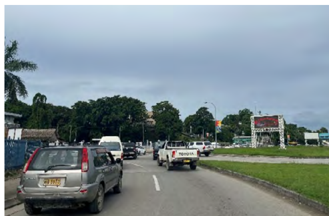
改修した道路と改良したラウンドアバウト
