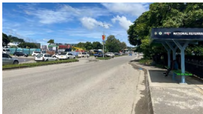
改修したクム幹線道路及び設置したバスベイ
