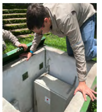
本事業により調達された機材の点検を行う環境天然資源省技師と維持管理ユニットチーム(事後評価現地調査中に撮影)
