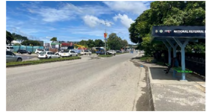
改修したククム幹線道路及び設置したバスベい
