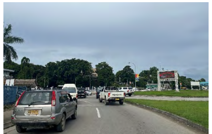
改修した道路と改良したラウンドアバウト
