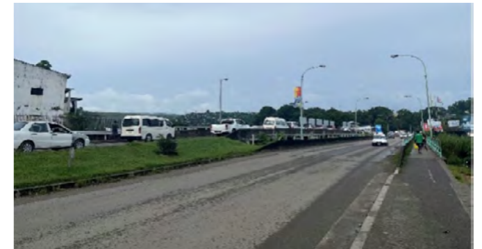
拡幅した新マタニコ橋（奥側が拡幅した2車線）
