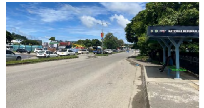
改修したククム幹線道路及び設置したバスベイ
