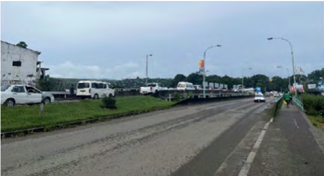
拡幅した新マタニコ橋（奥側が拡幅した 2 車線）
