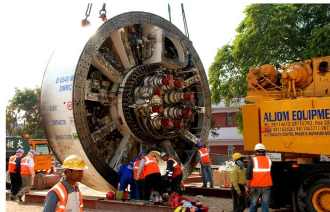
インド「デリー高速輸送システム建設事業」での全断面トンネル掘進機の組み立て
