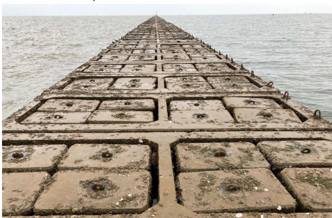
Cellular upper lid concrete blocks (quadrupartite)
