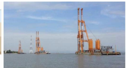
出典：五洋建設株式会社 CDM施工の様子（ラックフェン港）
