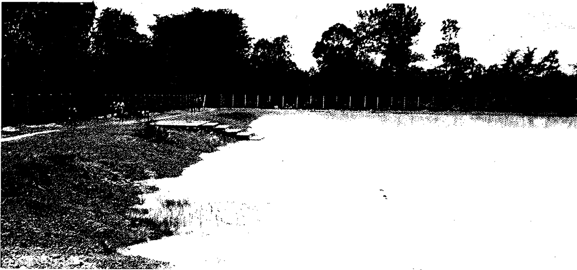
▲ムアン・サムシップ郡ヤン・ヨ・バブ区ノン・シ・マ村で、1986年4月に総事業費6万2千バーツで建設されたプラスチック敷溜池(50×40×4m)。村民50名が、シート敷や溜池周辺のフェンス作りの作業に参加し、15日間で建設。乾期の家畜飲料水、洗濯等の日常生活用水、また、農業用水としても利用されています。
